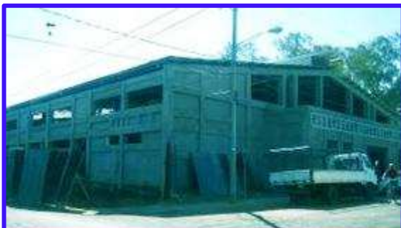
Instalaciones del Gimnasio Alexis Arguello. apreciar situación sin proyecto.
