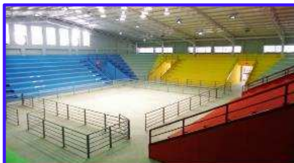
Vista interna de las Instalaciones del Gimnasio Alexis Arguello. observar las instalaciones del Gimnasio con el proyecto ya finalizado (área de cuadrilátero, graderías, pasillos de comunicación).
